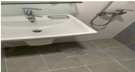
화장실1 (세면대 및 바닥 배수구)
